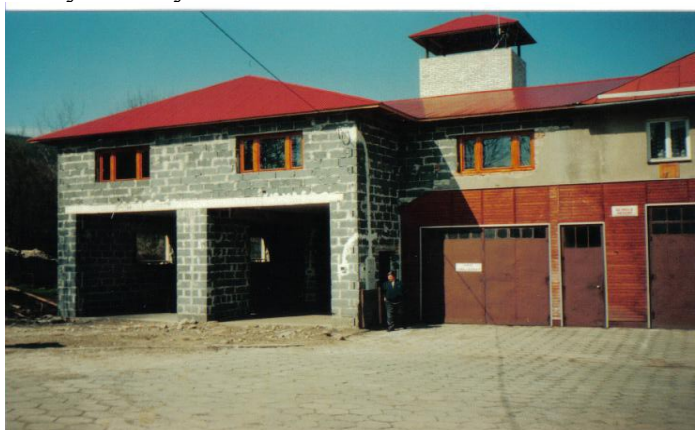
Zdjęcie nr 19. Budynek w trakcie rozbudowy. Stan z roku 2000
